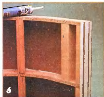
6 Крепить обшивку начинают так, чтобы ее первая полоса полностью расположилась на прямом участке изнутри, а не на скругленном торце. Выверив первую полосу обшивки по отвесу, ее крепят на клею и гвоздях.
